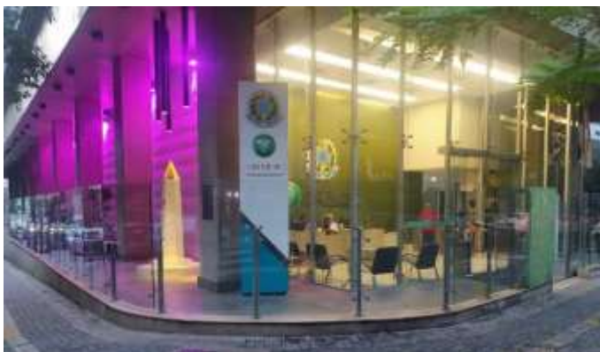
Figura 2 – Fachada do edifício do CREMESP depois da reforma (23/08/2023).
