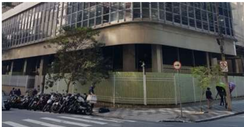
Figura 1 – Fachada do edifício do CREMESP antes da reforma.
