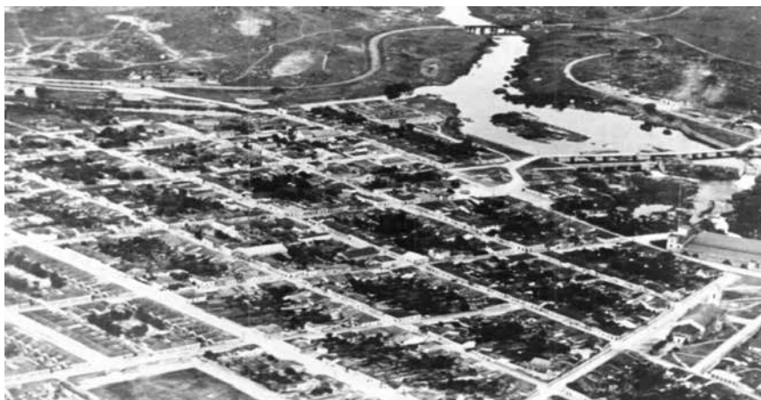
Foto da cidade em 1939, onde se vê o Cine Rui Barbosa ainda em construção (assinalado)
